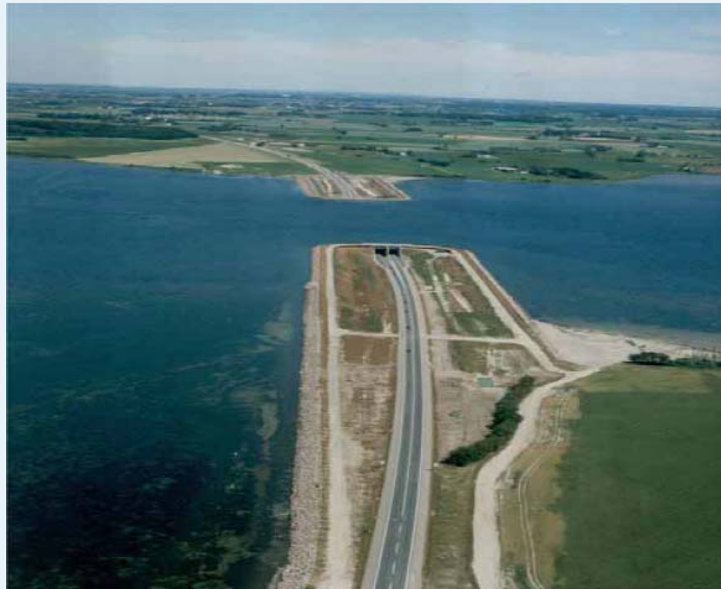
Short Immersed Tunnel Solution (Vejdirektoratet)
